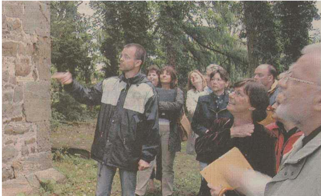
Die Mauer ist freigelegt: Denkmalpfleger Ralf Niemeyer zeigt den Kommunalpolitikern, wo die Euwatec-Arbeiter das Mauerwerk des Stumpfen Turms vom Efeu befreit haben. FOTO: Wolf
